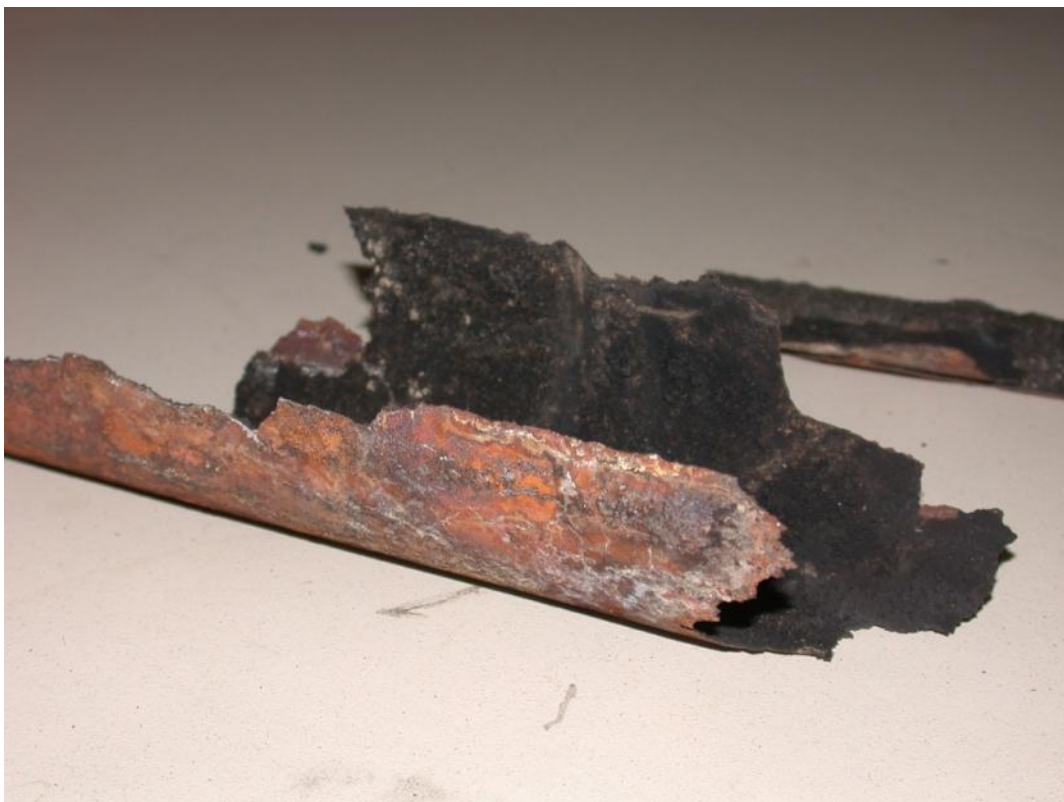
Korrosion und Ablagerungen aus den Wärmetauschern nach 4- wöchigem Stillstand
