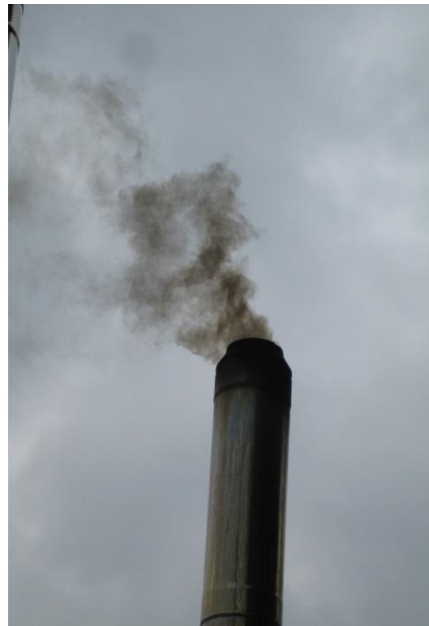
Erhöhte Emissionen während der An- und Abfahrvorgänge
